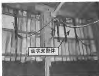
写真-1 面状発熱体取付け状況
