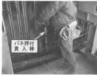
写真-3 貫入試験状況
