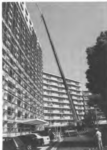
図-1 補助ジブ作業状態
