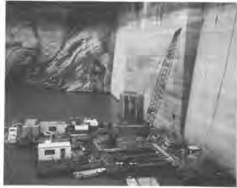
写真-1 施工状況
