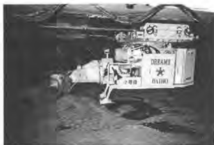
写真-1 ケーソン掘削機
