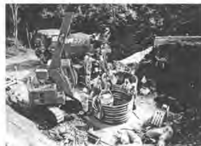
写真-2 道路橋橋脚基礎
