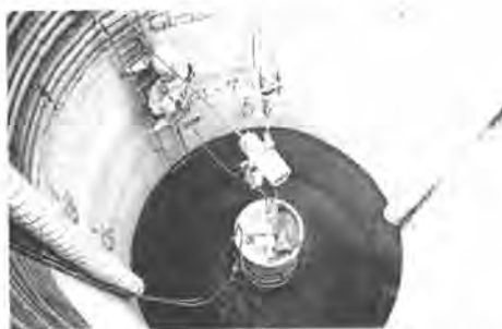
写真-1 作業状況(南いわき幹線)
