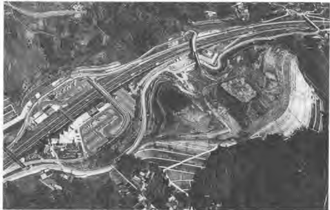
写真-1 談合坂 SA 盛土部現況
