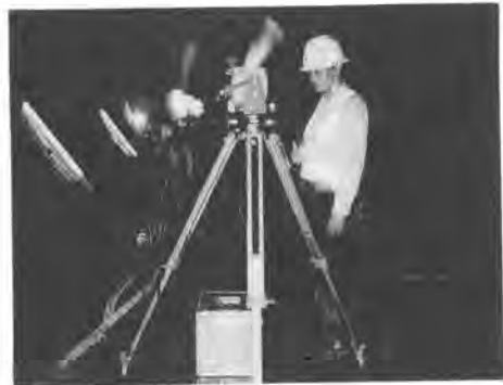
写真-3 一次覆工測定状況
