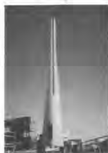
写真-2 電源開発(株)磯子火力発電所
