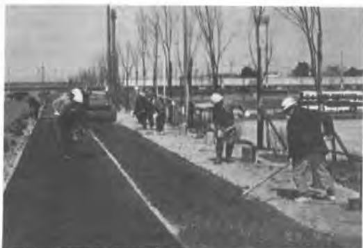
写真-5 人力施工状況
