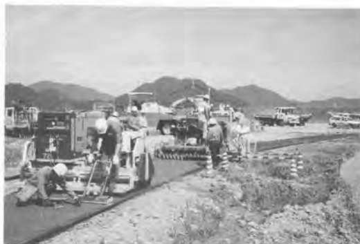
写真-6 機械施工状況
