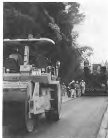
写真-2 マルチレーン施工現場
