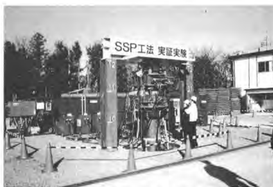
写真-1 実証実験状況
