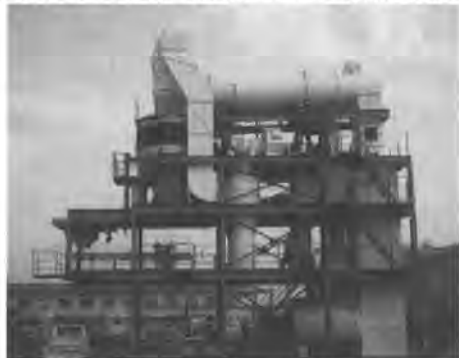
概観写真1 直接燃焼式脱臭装置付 リサイクル装置
