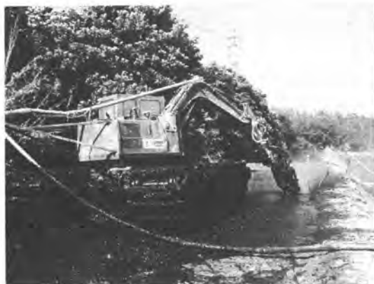
写真-2 小型泥上車+トレンチャー
