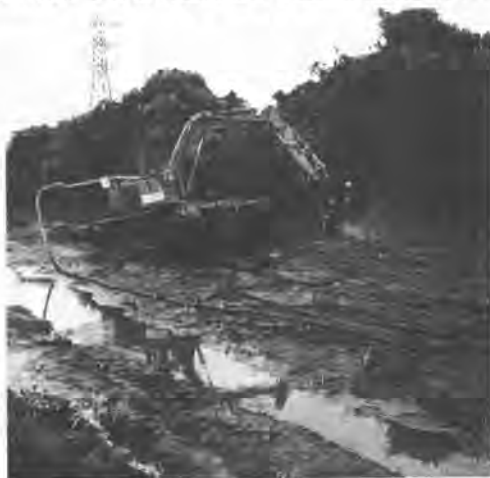
写真-4 PJマッドスタビ工法施工状況
