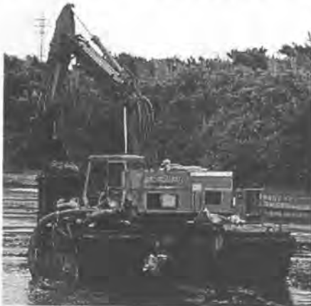
写真-5 浚渫状況
