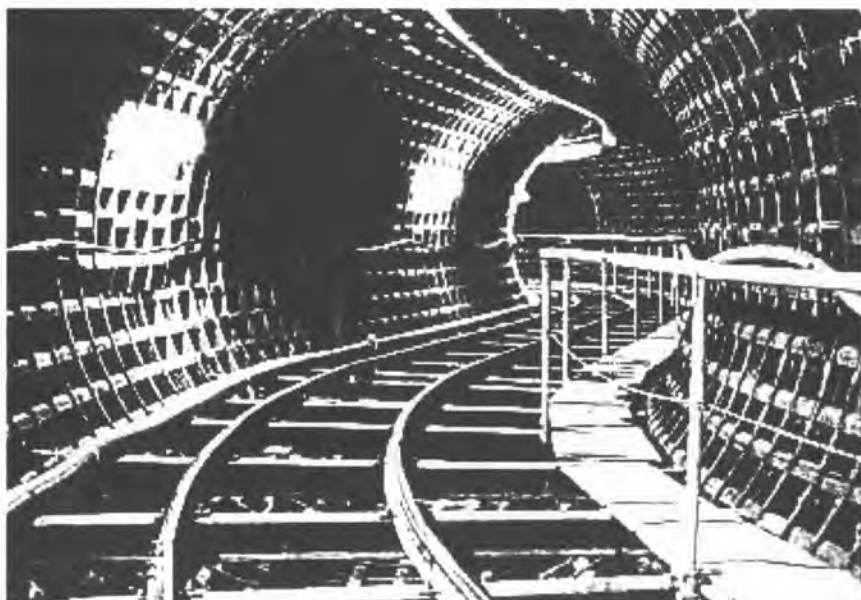
写真-2 S字状の急曲線部 (半径 12m)
