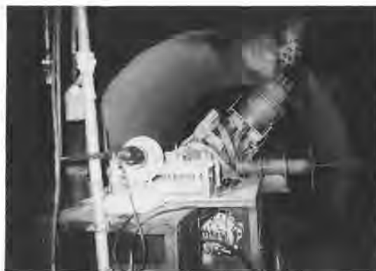
写真-1 はつり除去施工状況
