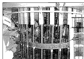
写真-9 中間フレーム取付
