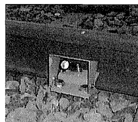
写真-5 ターゲット設置状況
