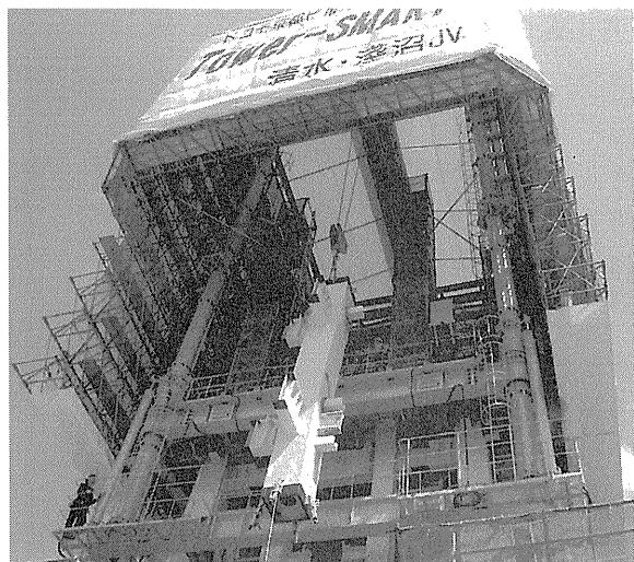
写真2. 荷取構台からシステムによる揚重
