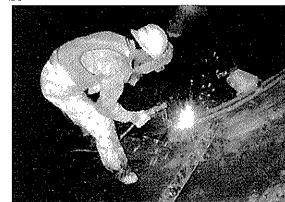
写真-9 スペーサ溶接固定
