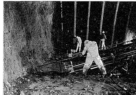
写真-2 実現した遠隔装填作業
