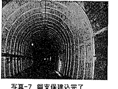
写真-7 鋼支保建込完了
