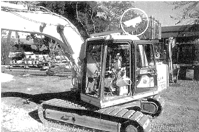
写真-1 張出しカメラ取付け状況
