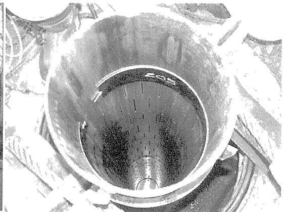
写真-6 補修材装着状況
