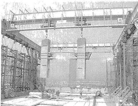
写真-3 PCa柱施工状況
