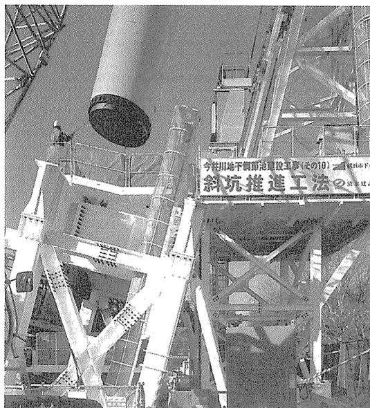
写真-2 推進管投入状況
