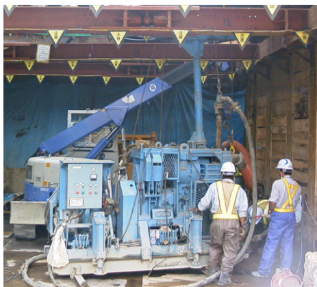
写真-1 施工状況
