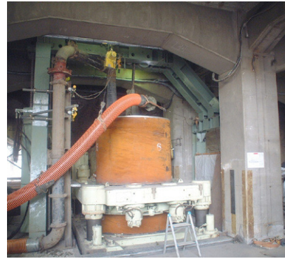
写真-4 施工状況
