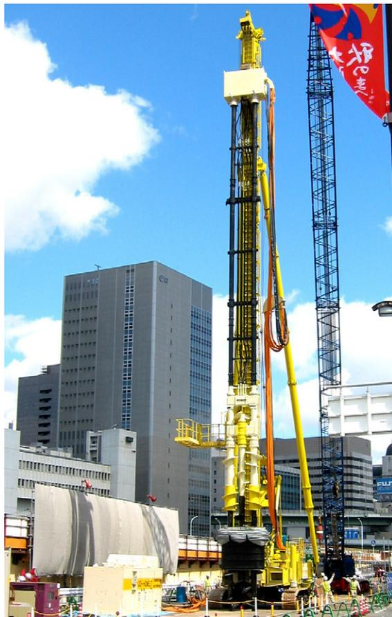
写真-1 三点式杭打機による施工状況
