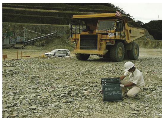
図-8 重ダンプトラックによる転圧状況
