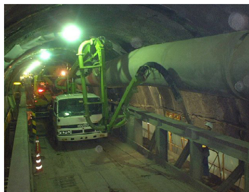
画ー2 コンクリート打設状況
