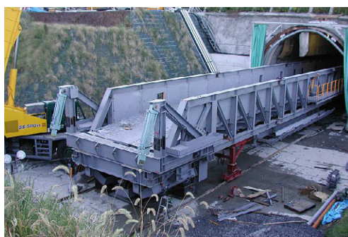
画ー1 インバート栈橋組立て搬入
