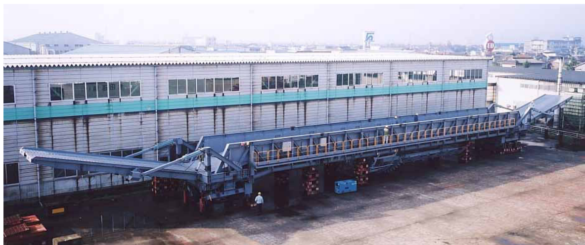
画ー3 インバート栈橋全景
