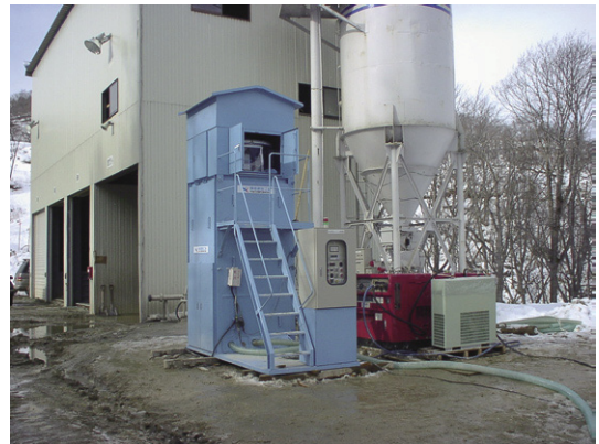
写真3 非鋼繊維補強コンクリート現場施工状況
