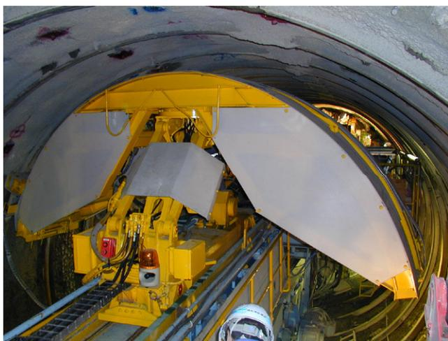
写真-2 吹付けロボット
