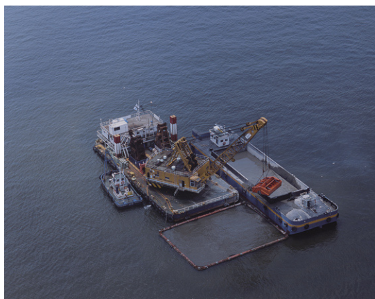
写真－4 広島港での浚渫状況
