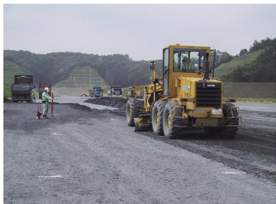
写真-4 レーザ検測時の施工状況
