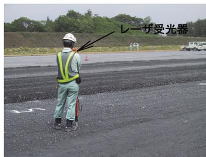
写真-2 レーザ受光器による検測状況
