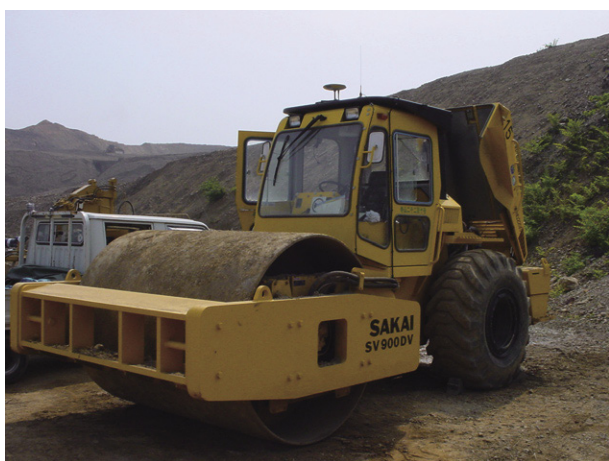
写真－1 転圧振動ローラー設置状況
