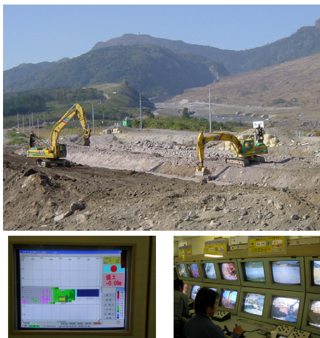
図－1 最近の無人化施工の事例
