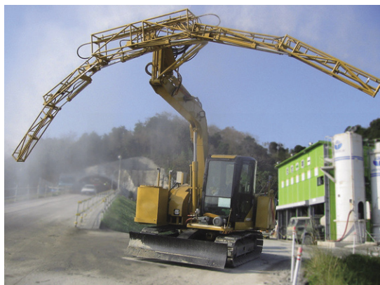
写真1 自走式噴霧養生装置（噴霧状態）
