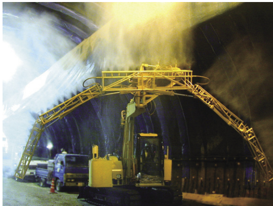
写真5 トンネル坑内での試運転状況
