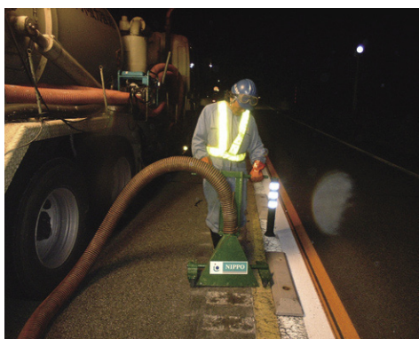
写真－13 高機能舗装面の清掃状況
