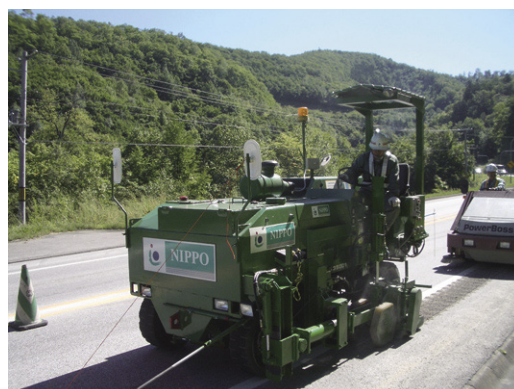
写真－11 ショルダー施工状況
