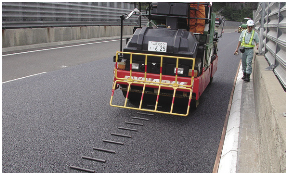
写真-3 ローラ転圧状況
