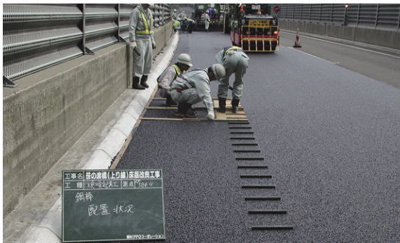
写真-2 丸鋼の配置状況
