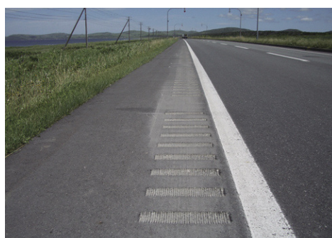
写真－12 設置完了状況
