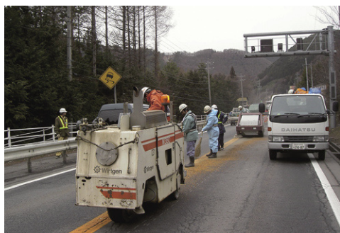
写真－9 センター施工状況
