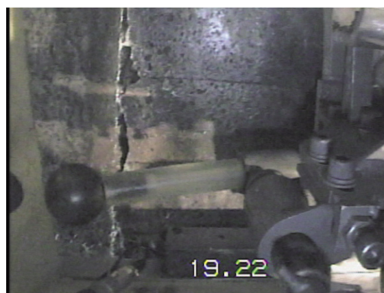
図-9 覆工壁面の画像
