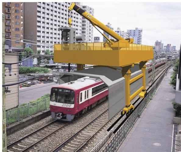
図-3 移動式直接高架施工機による施工イメージ図
