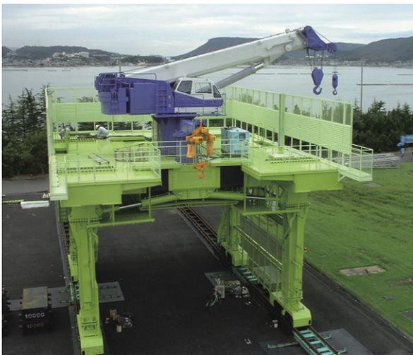
写真-2 柱梁架設用高架施工機仮組状況
