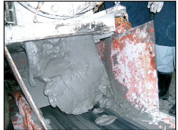
写真2 推進機ゲートから排出される固結シルト
