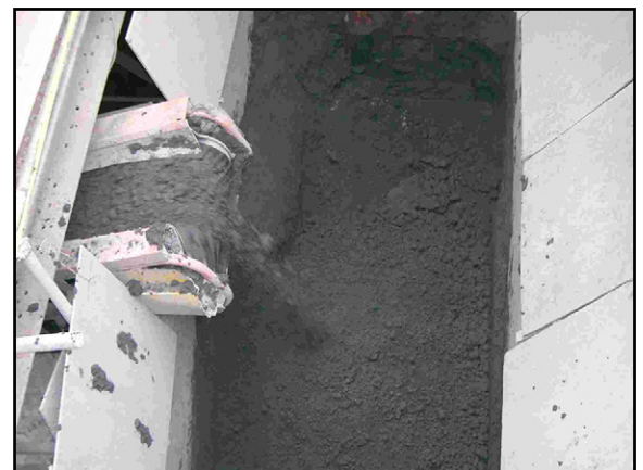
写真3 改良土（第4種建設発生土以上）
