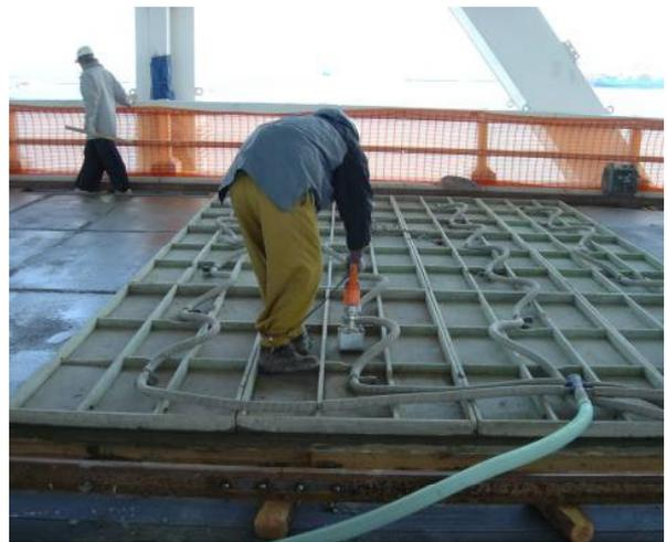
写真-2 真空脱水工法
