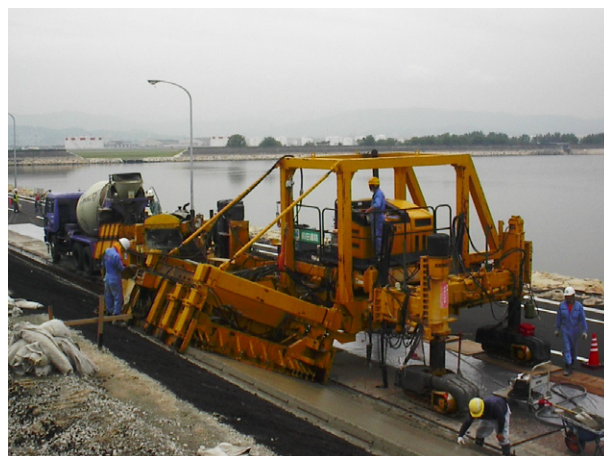
写真-3 岩国工事の施工状況
