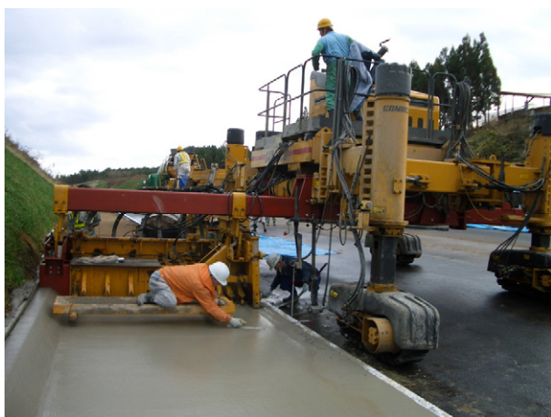
写真-2 ニツ山工事の施工状況
