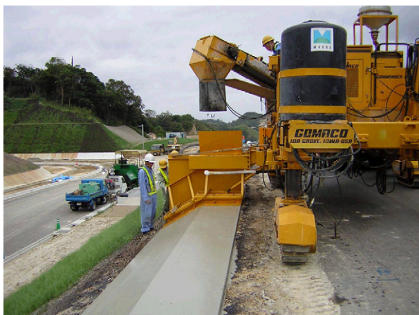
写真-1 江津工事の施工状況（盛土部）
