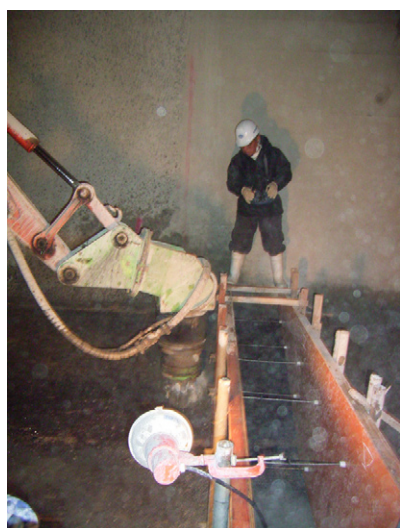
写真—7 型枠際の施工
