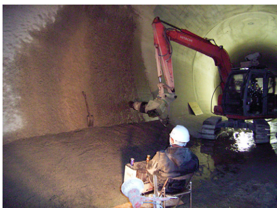
写真—6 ロボQ近傍運転
