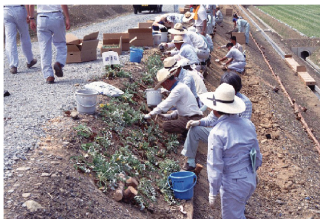
写真－1 人力によるGCPの植栽状況
