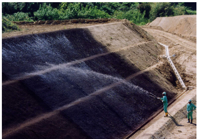
写真－3 苗の吹付状況
