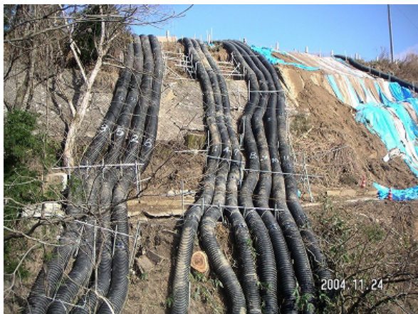
写真－8 下り勾配部分では配水管に取替えられた
