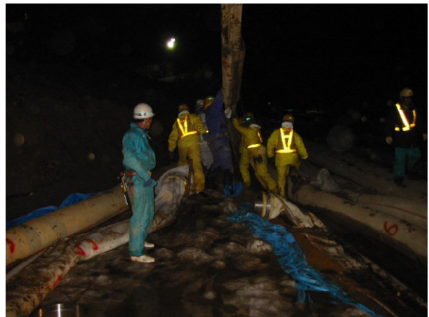
写真－6 排水ホース移設作業状況
