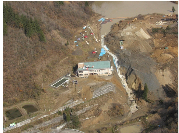
写真－5 排水による洗掘で斜面の崩落が進行
