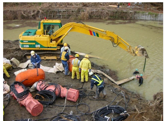
写真－9 排水ポンプの投入状況
