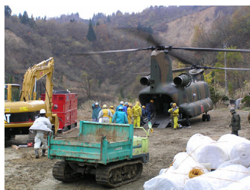
写真－1 自衛隊大型ヘリで輸送されたミニクローラックと組立が完了し稼働中の油圧ショベル
