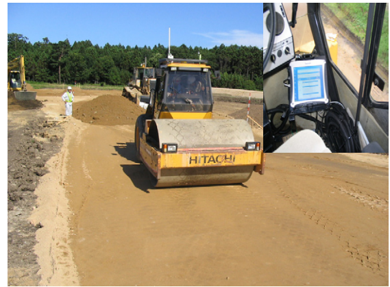
図—5 施工状況及び車載モニタ締固め作業の概要を以下に示す。
