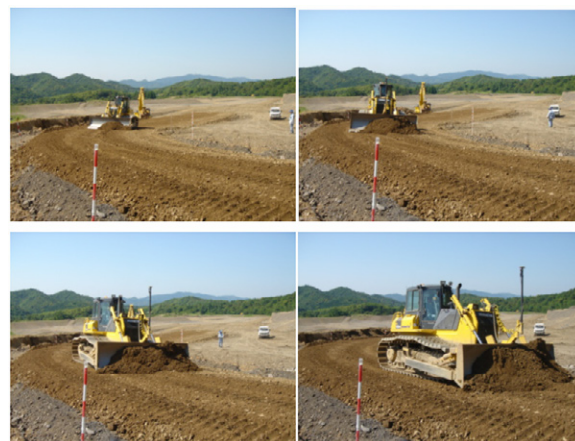
図13 テスト施工の様子
