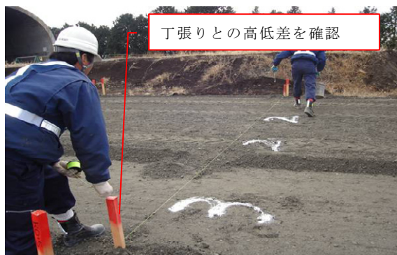
写真－１ 現行路盤整形作業時の確認作業
