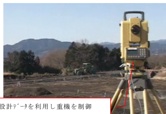
写真－２ 路盤整形後の状況
