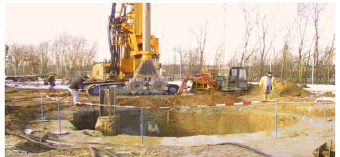
写真-3：円形立坑施工状況
