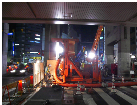
写真－2 TBH 機削孔機
