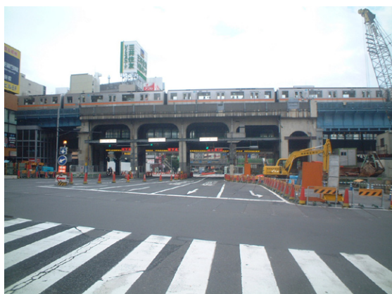
写真－1 施工箇所
